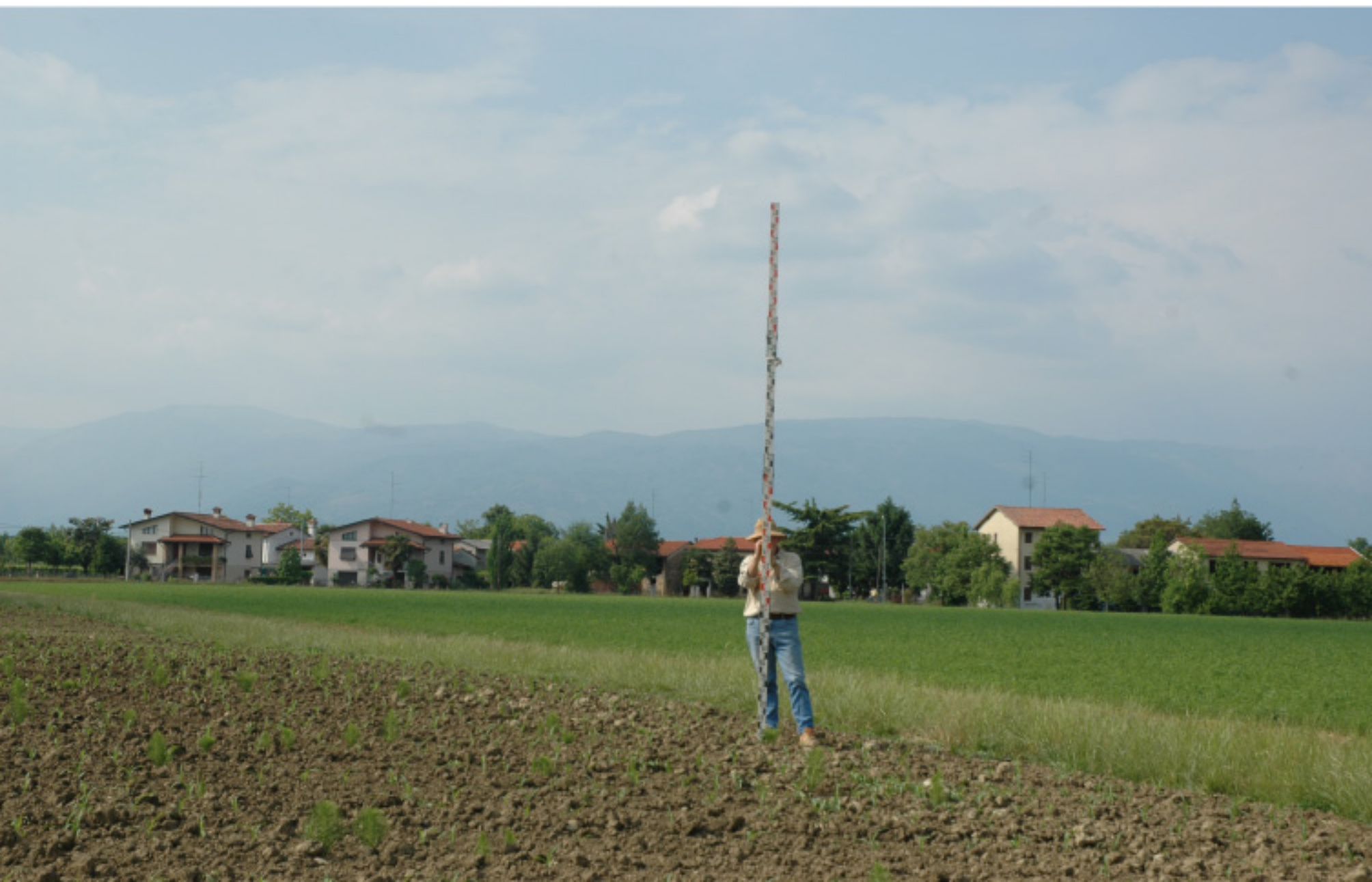
Foto N. 7 Traliccio 13A visto da sud
