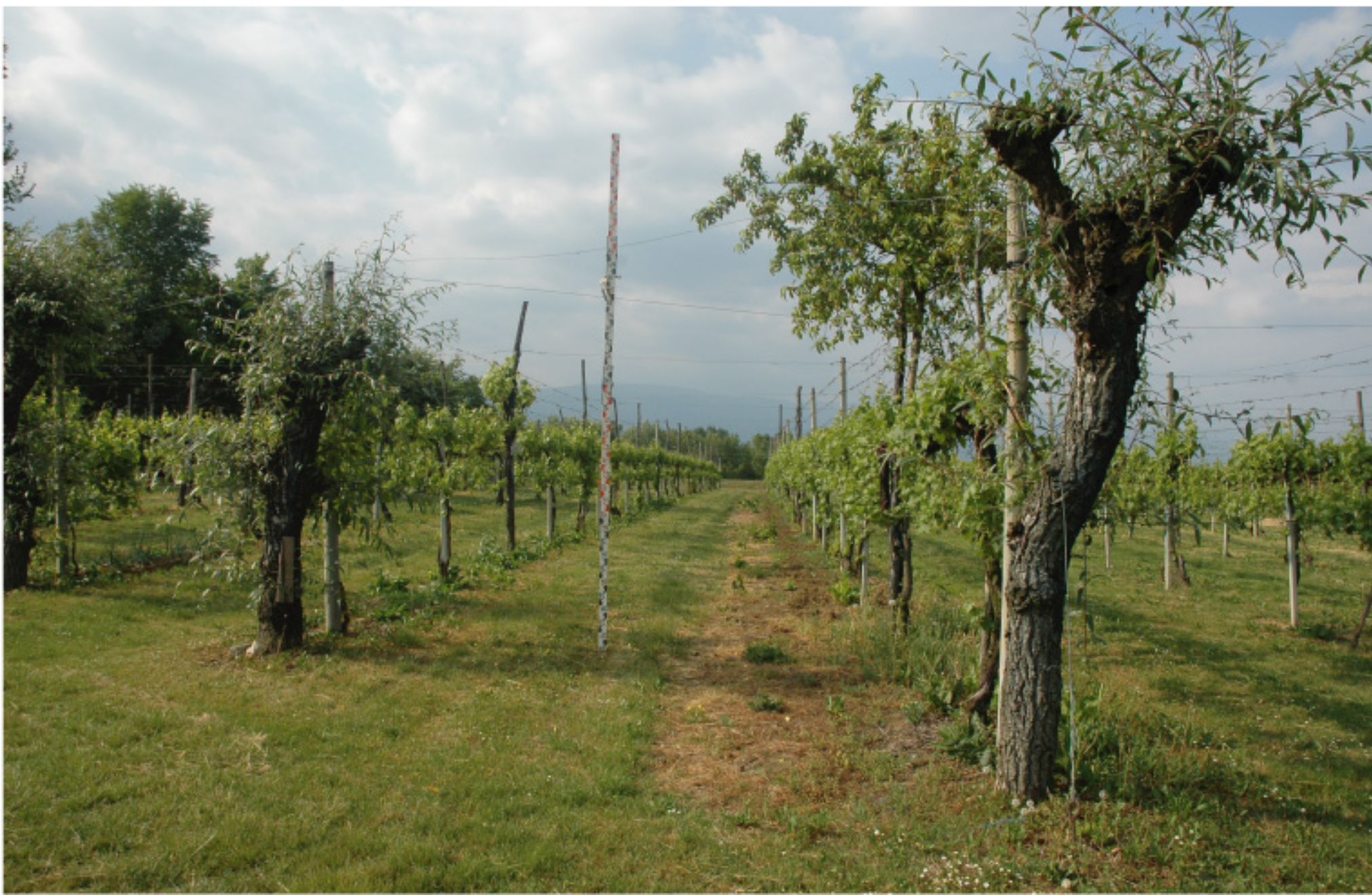
Foto N. 11 Traliccio 11A visto da sud
